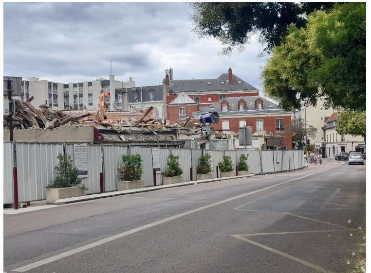
2) Vue des bâtiments démolis – août 2025
