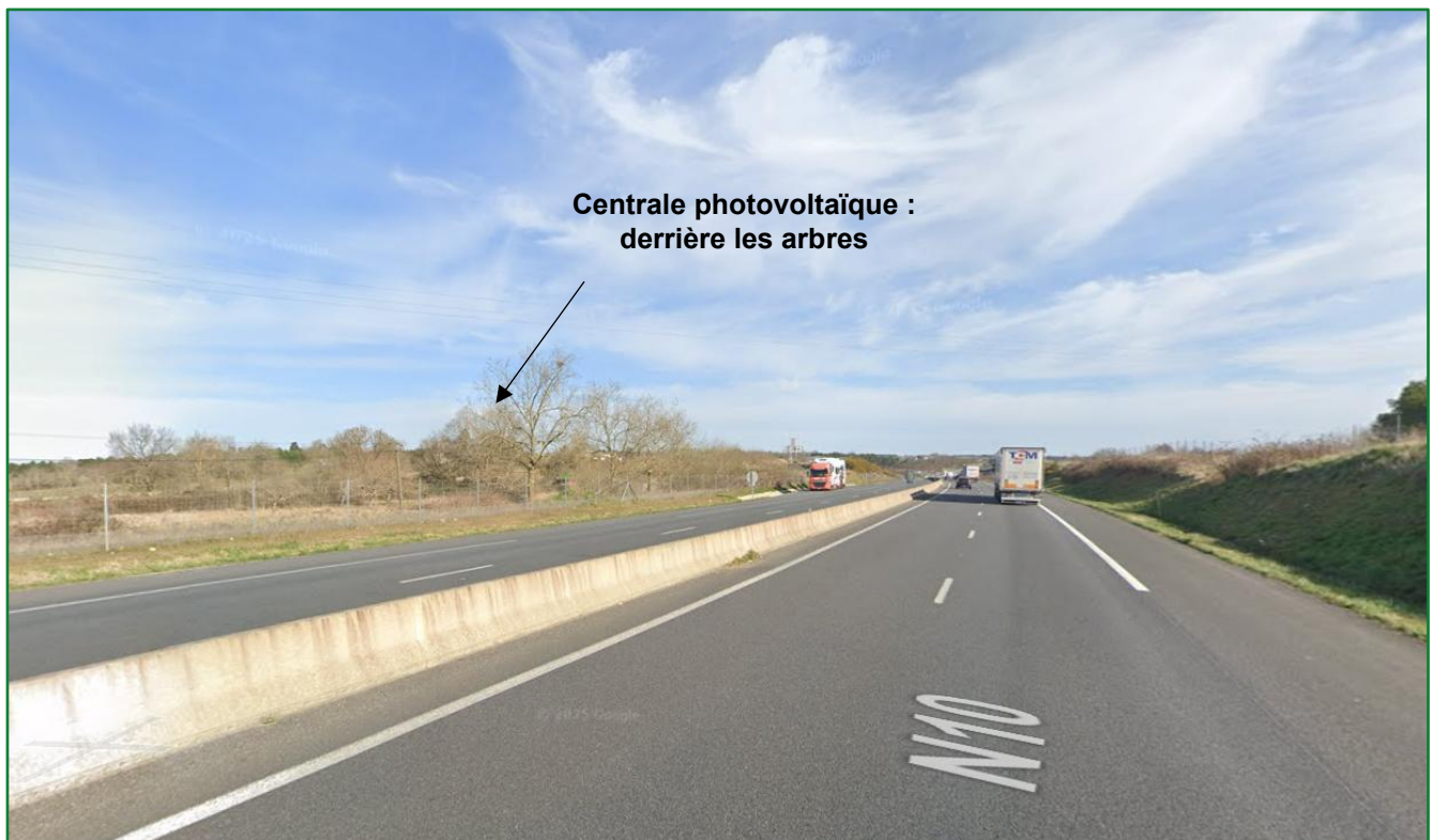
Vue n°2 : vue éloignée depuis la route nationale 10 (Date photo : mars 2025, Google Maps)
