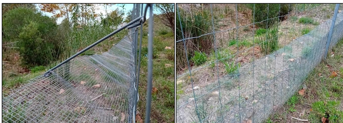
Exemples d'une clôture petite faune constituée d'un grillage à maille 6x6 mm pourvu d'un rabat anti-escalade incliné à 45° vers l'extérieur et soutenu par des bavolets. La clôture petite faune en question est plaquée sur une clôture classique.
