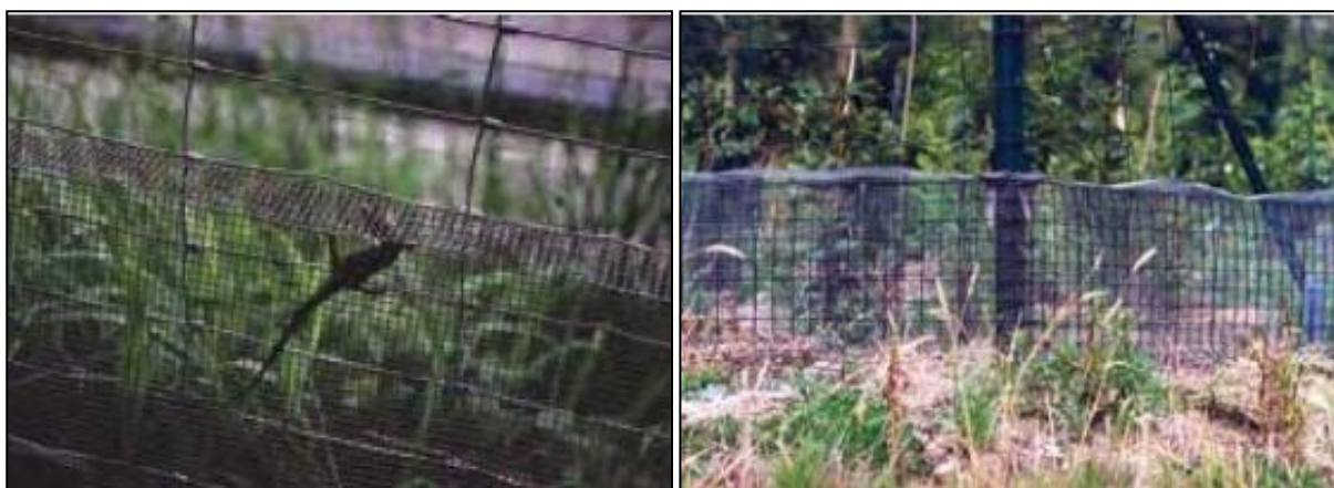
Exemples de clôtures à petites mailles dont la partie supérieure est inclinée et dont la partie inférieure est enterrée. Les clôtures en question sont plaquées sur une clôture classique.
