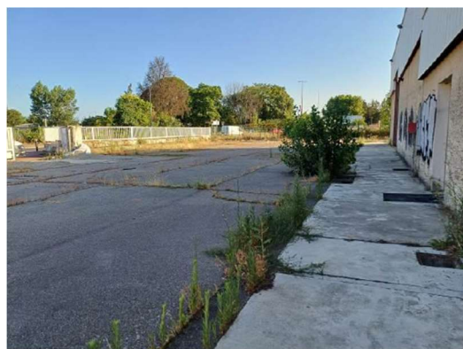
Parking et dalle béton entourant le hangar
