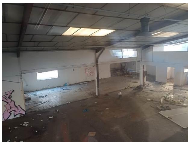
Vue d'ensemble de la pièce n°5 depuis l'étage
