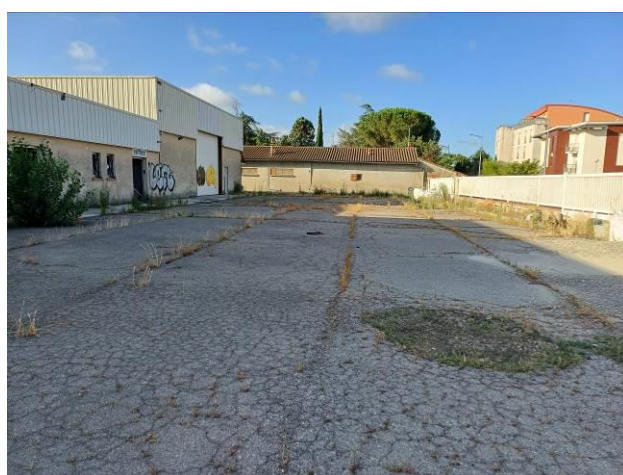
Vue d'ensemble du site, partie sud
