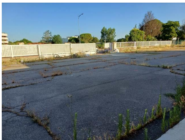
Portail d'accès du site
