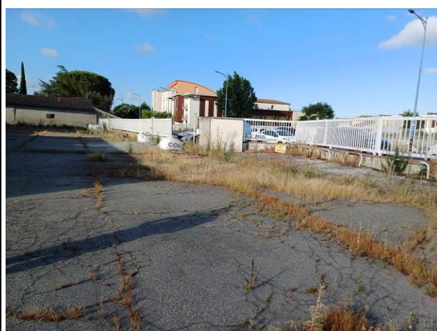
Clôture et accès au site, partie sud
