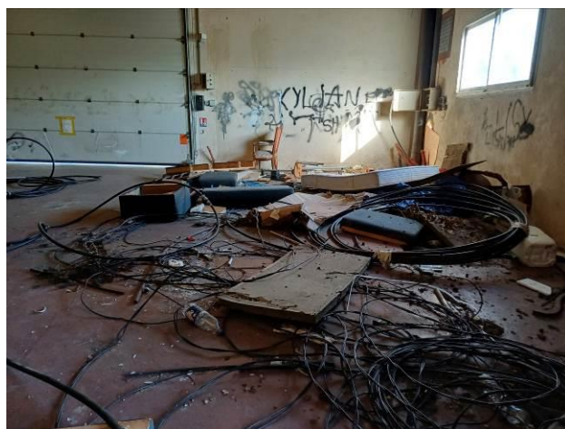
Dépôt sauvage de câbles et autres déchets dans la pièce n°1
