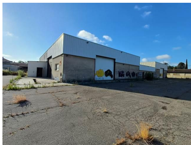
Vue d'ensemble du hangar et de l'aire de lavage
