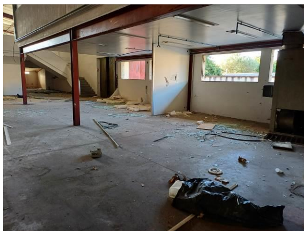
Pièce n°5 avec la présence de l'ancienne chaufferie au gaz
