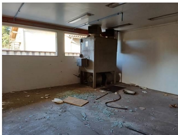
Ancienne chaufferie (pièce n°5)
