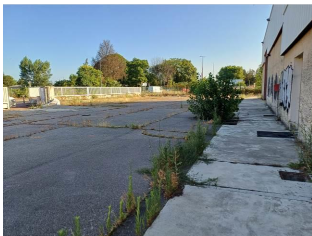
Parking et dalle béton entourant le hangar
