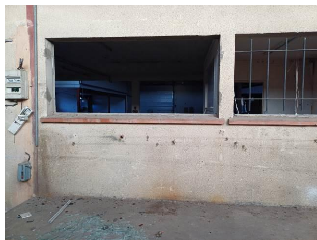
Pièce n°5 (gauche) et pièce n°3 (droite) depuis la pièce n°7
