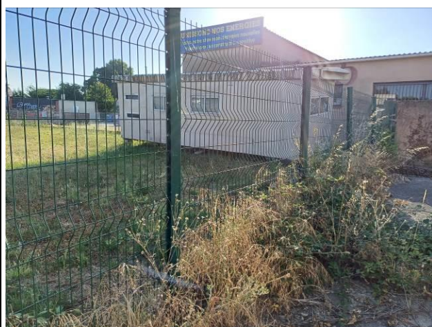
Bungalow présent au droit de la partie nord, à l'abandon
