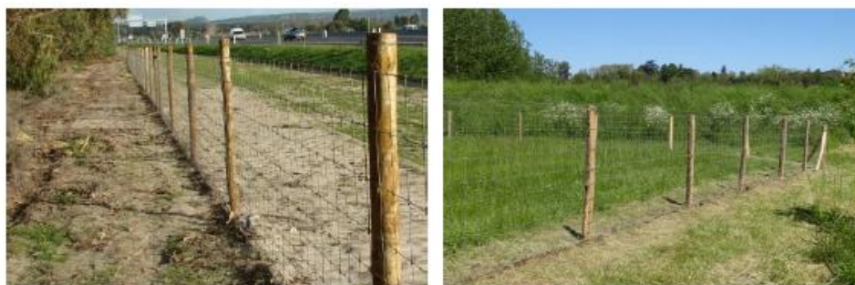
Figure 12 : Exemple d'une clôture de parc solaire
