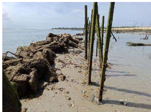
Prise de vue le 27/05 à 12h13 vers le Sud et l'enrochement en bon état : aperçu de la portion d'enrochement en bon état, par l'arrière de laquelle des piquets béton plantés parviennent à se maintenir
