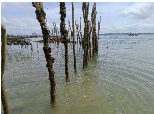
Prise de vue le 27/05 à 11h59 : pignolage serré présent, à défaut d'un retour d'enrochement.
