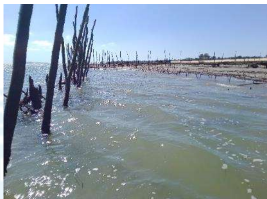
Prise de vue à 13 h 42 le 31/03 : vue de la partie non exploitable, zone d'érosion du bas de parc, non accessible à basse mer (plus de 1 m d'eau).
