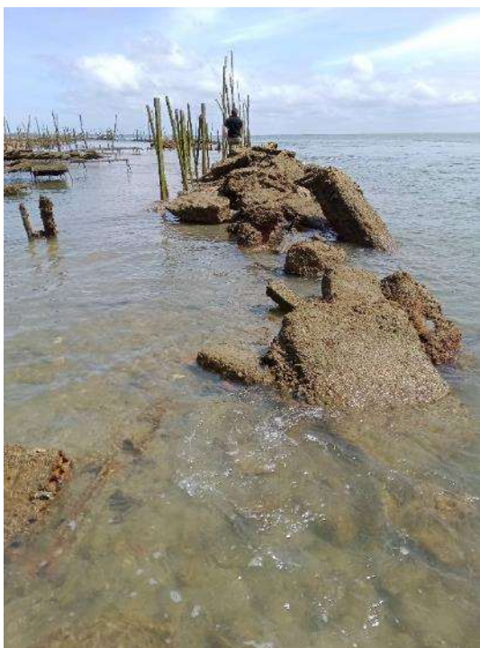
Prise de vue le 27/05 à 12h11 vers le Nord et l'enrochement en bon état, depuis la fin de la brèche
