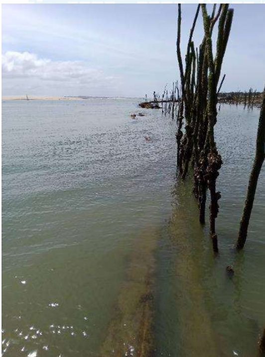
Prise de vue 12 h 48 le 27/05/2025 : vers le Sud, partie sous l'eau de l'enrochement
