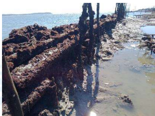
Prise de vue 13 h 54 le 31/03 du Nord vers le Sud: enrochement en bon état. 0,2 m de hauteur d'eau
