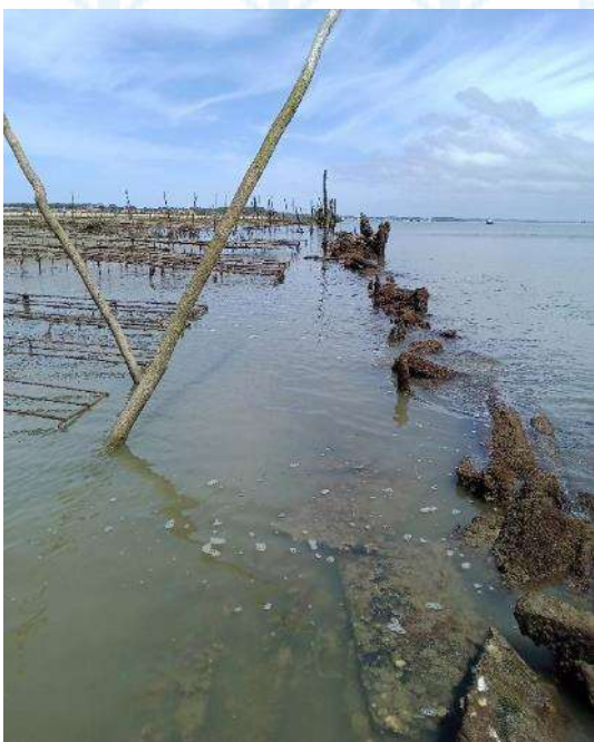
12h 54 le 27/05 : même vue de l'enrochement depuis le sud , 0,58 m de hauteur d'eau
