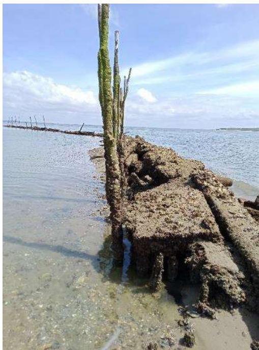
Prise de vue 12 h 23 le 27/05 : partie Sud de l'enrochement zone 5
