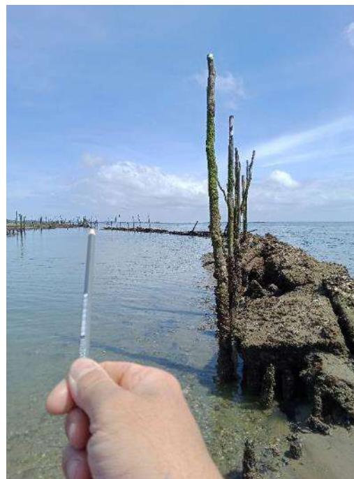
Prise de vue 12 h 23 le 27/05 : vue globale de l'enrochement zone 5 (fin de zone à la pointe du crayon)
