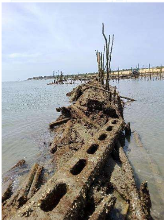
Prise de vue 12 h 27 le 27/05 : vue vers le sud depuis le point bas de l'enrochement plus au Sud, dans l'angle
