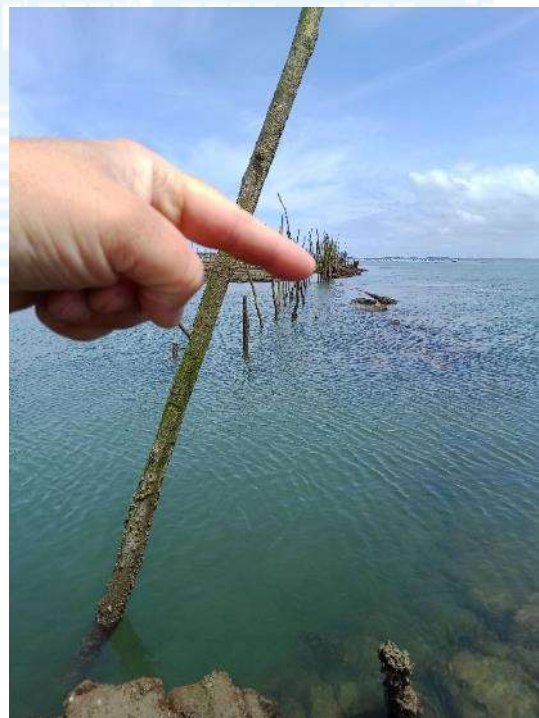
Prise de vue 12 h 35 44 le 27/05/2025, du Sud vers le Nord, depuis la fin de l'enrochement en zone 5 en bon état. Doigt qui pointe vers le point de prise de vue de 12 h 48.
