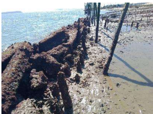
Prise de vue à 13h 38 le 31/03, du Nord au Sud, tronçon d'enrochement en bon état.
