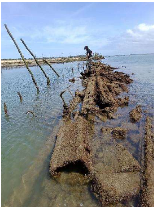
Prise de vue 12 h 30 le 27/05 : vue vers le Nord depuis le point bas de l'enrochement le plus au Nord
