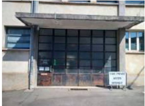
Photographie D : Entrée du Service Opérationnel Voirie
