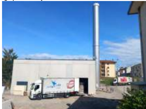
Photographie E : Projet de chaufferie relais en cours de construction
