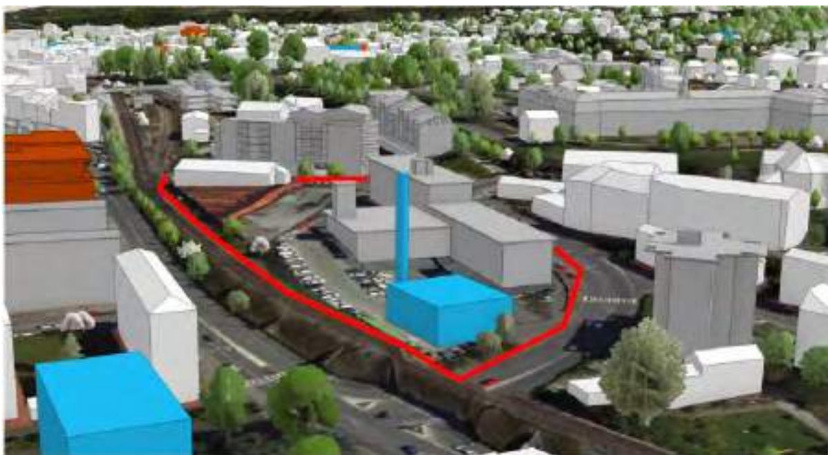
Figure 8 : Vue ouest->est du site avec le projet de chaufferie d'appoint en cours de construction (en bleu) (Source : Ville de Thonon les Bains)
