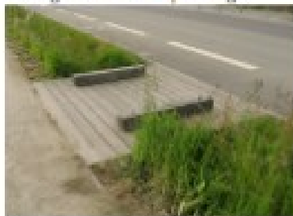
Passage sur noue en platelage
