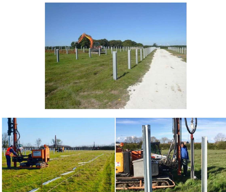
Figure 3 Illustration des pieux battus mis en œuvre avec profil en coupe
