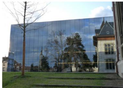
Façade réfléchissante et vitrage pare-soleil
