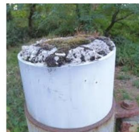
Suppression des cavités dangereuses en bouchant les tuyaux
