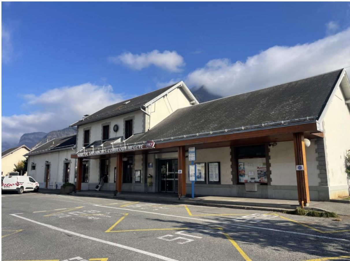
FIGURE 2 GARE DE SALLANCHES-COMBLOUX-MEGEVE (SOURCE : SNCF)
