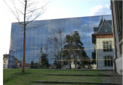
Façade réfléchissante et vitrage pare-soleil
