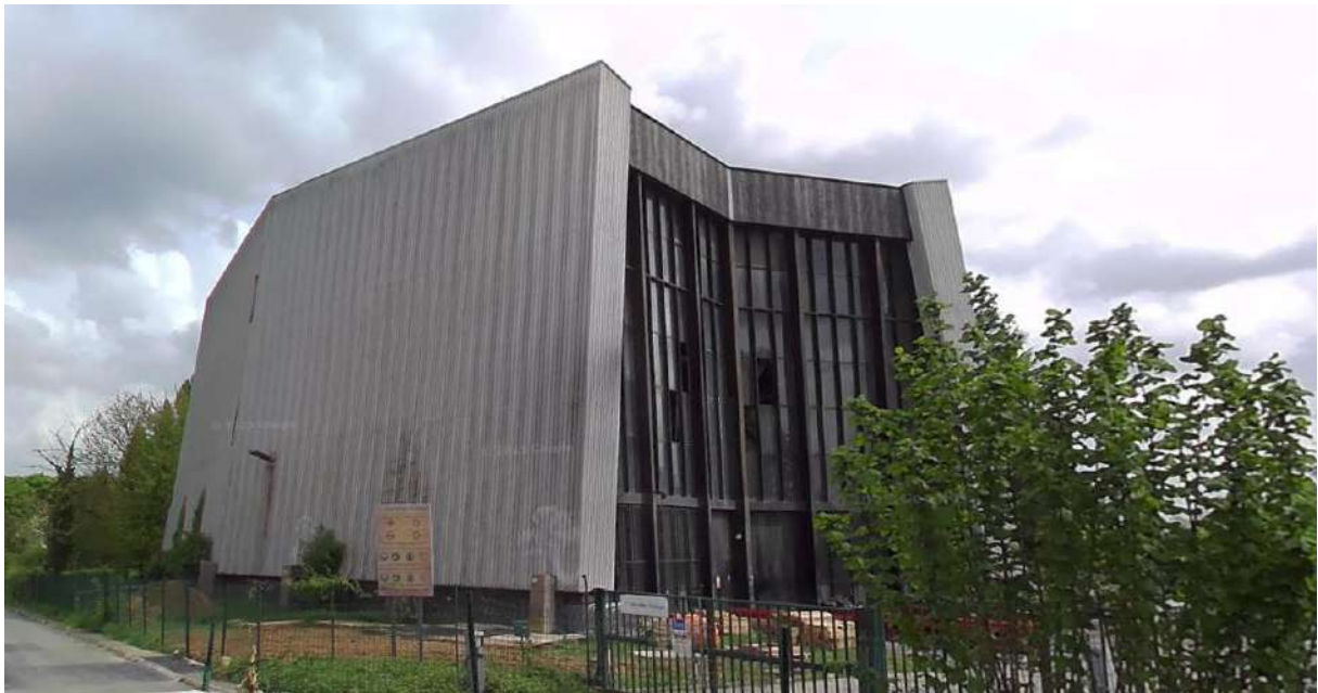
Figure 8: Vue de l'ancienne centrale à fioul à partir d'avenue de division leclerc D316. (Google earth, street view, Déc 2025).
