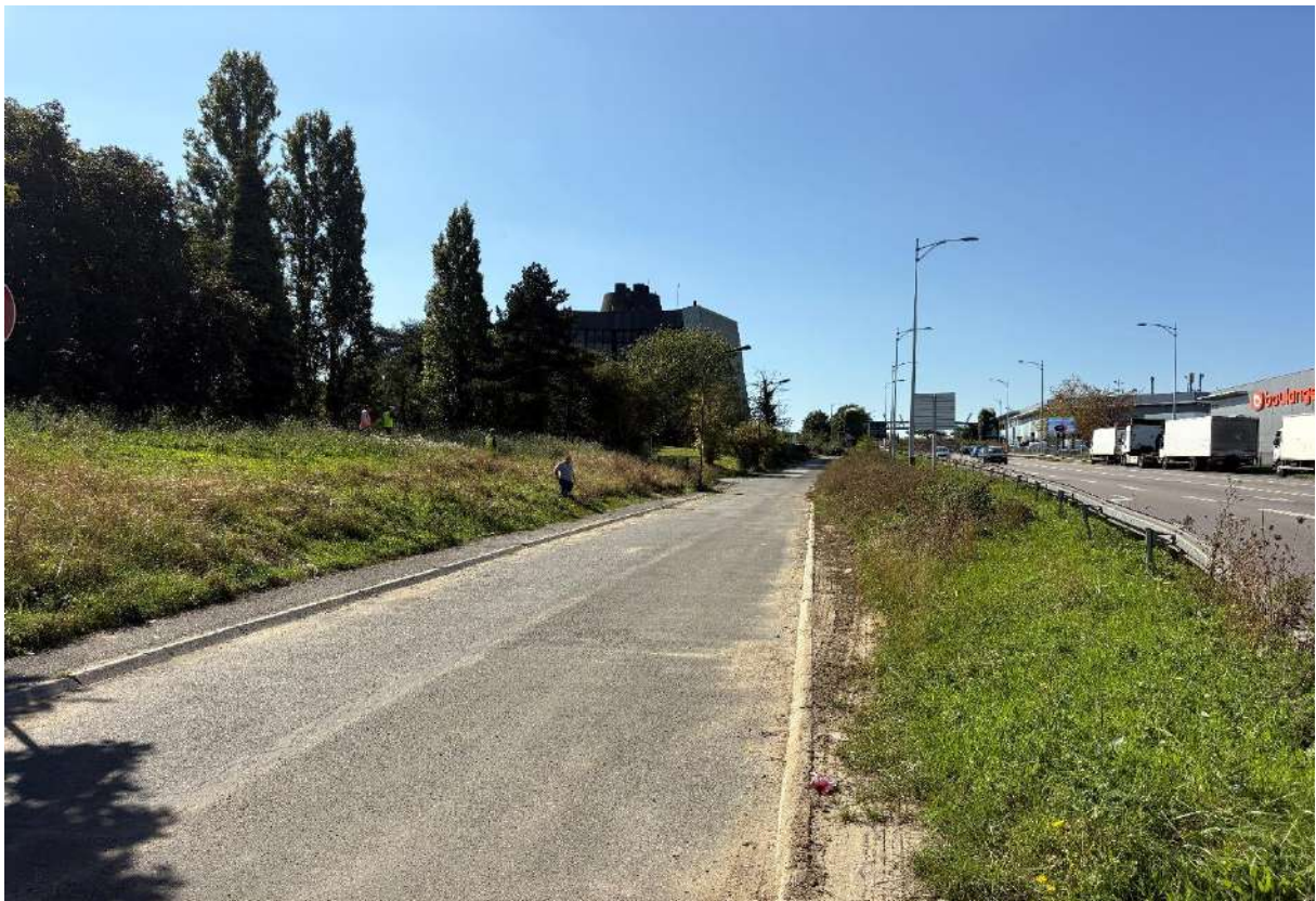
Figure 5: Accès au site depuis l'avenue de D316.
