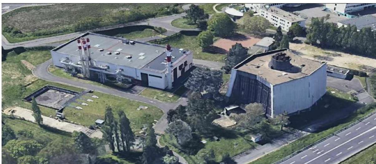
Figure 11: Vue aérienne lointaine du site de projet. (Google earth, street view, Déc 2022).
