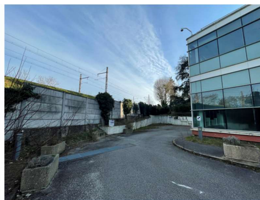
Vue 6 Vue de la voie ferré
