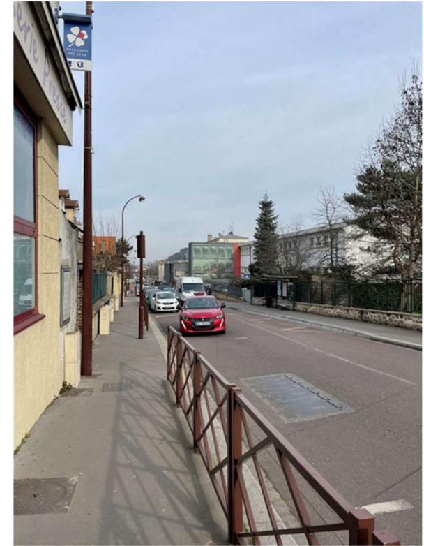
Vue 10 Vue du bâtiment rue au fond depuis l'angle de la rue Yves le Coz et la rue du Pont Colbert
