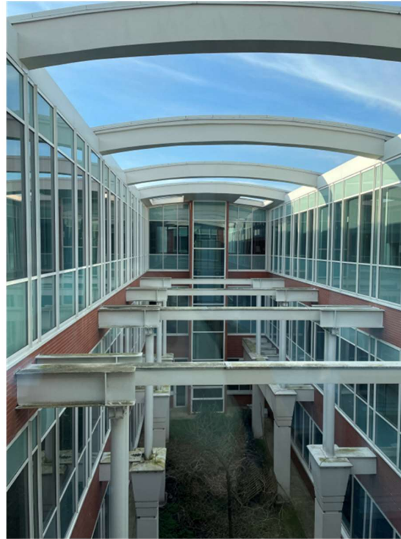
Vue 9 Patio intérieur du bâtiment jardin
