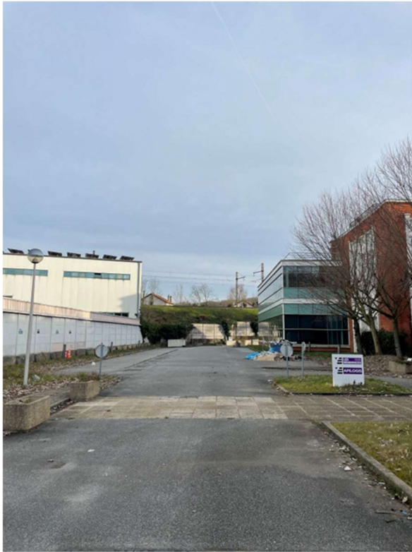
Vue 8 Parking nord du bâtiment jardin
