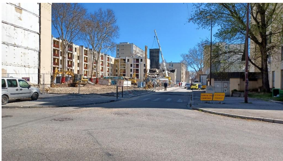
Photo 5 : Chantier de déconstruction en cours (Citadia Mars 2025)
