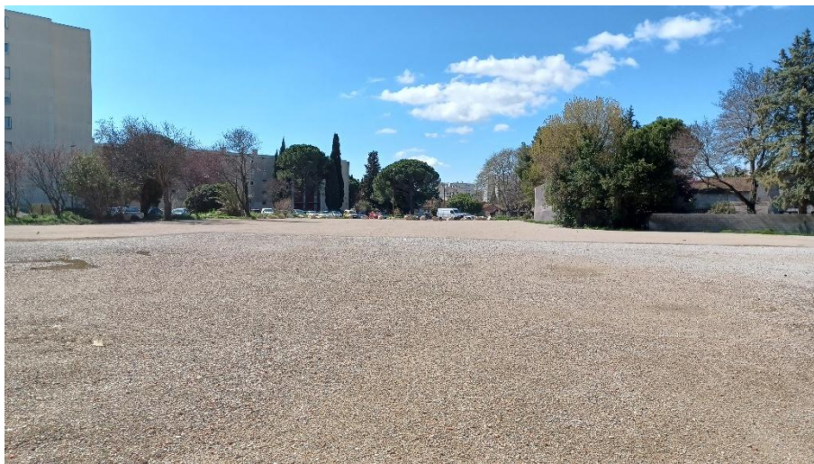
Photo 9 : Espace vacant résultant des récentes déconstructions (Citadia Mars 2025)
