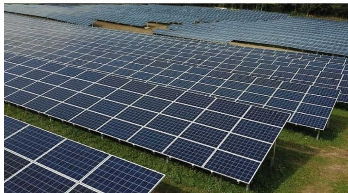
Figure 2 : Exemple de table photovoltaïque sur pieux
