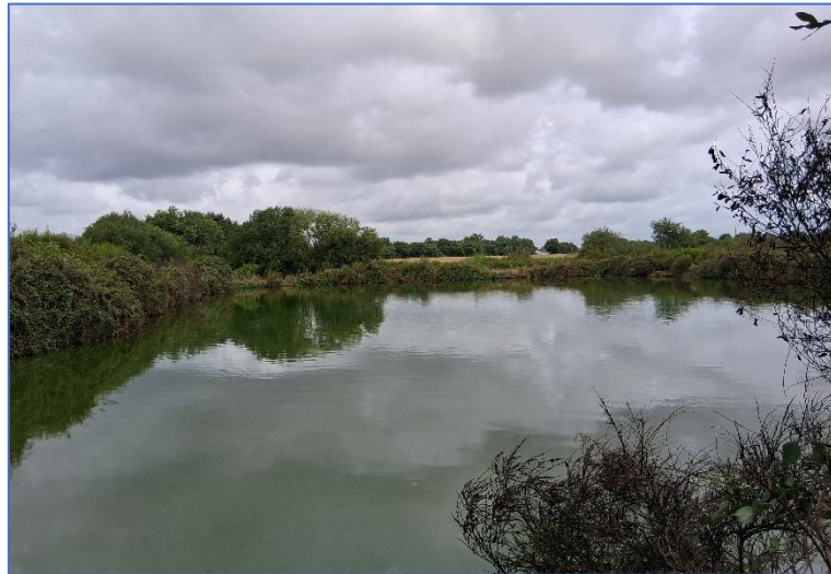
Figure 32 : Lagune d'assainissement au Nord-Ouest du périmètre [AGGRA Concept, 22/07/2025]
