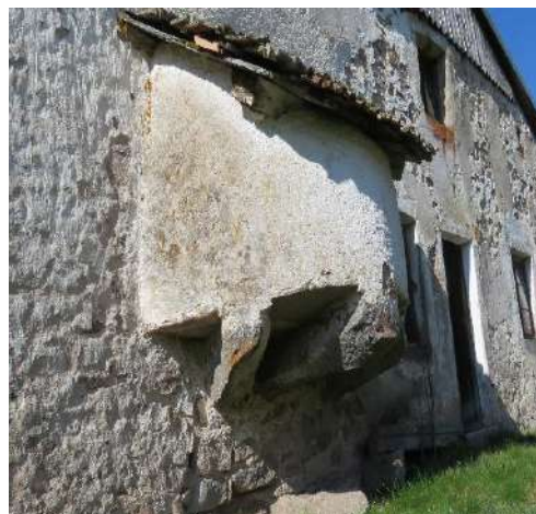
four à pain en façade
