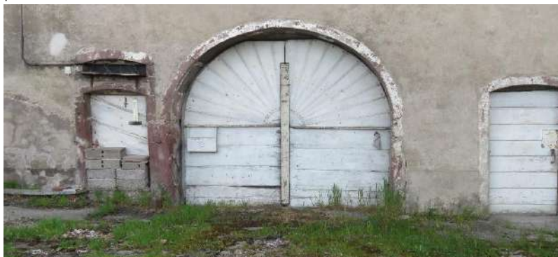
mur gouttereau avec sa porte charretière avec des encadrements en grès, porte soleil
