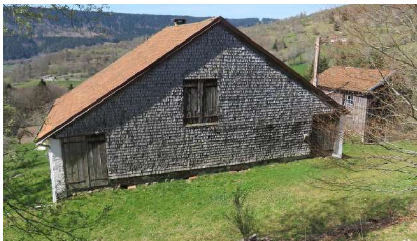
Mur arrière avec ossature en planches recouvertes d'essis
