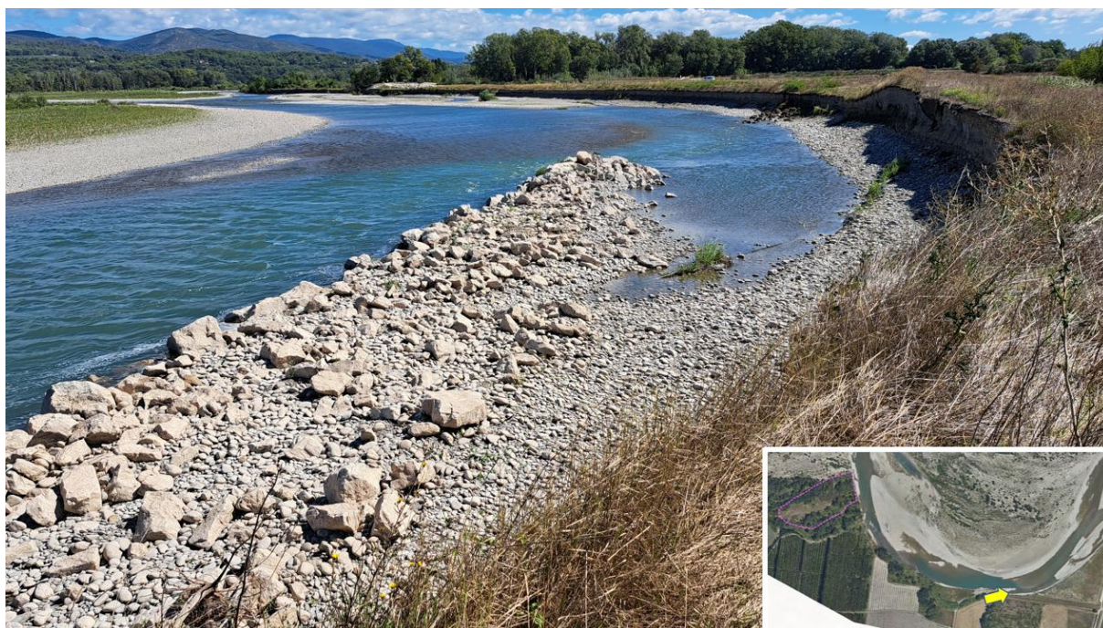
Figure 4 : Anse d'érosion en amont du site de la décharge, état avant travaux
