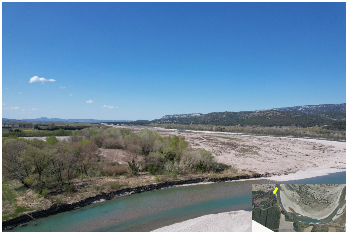
Figure 2 : Vue drone n°1 du site projet et de la décharge de Charleval avant travaux
