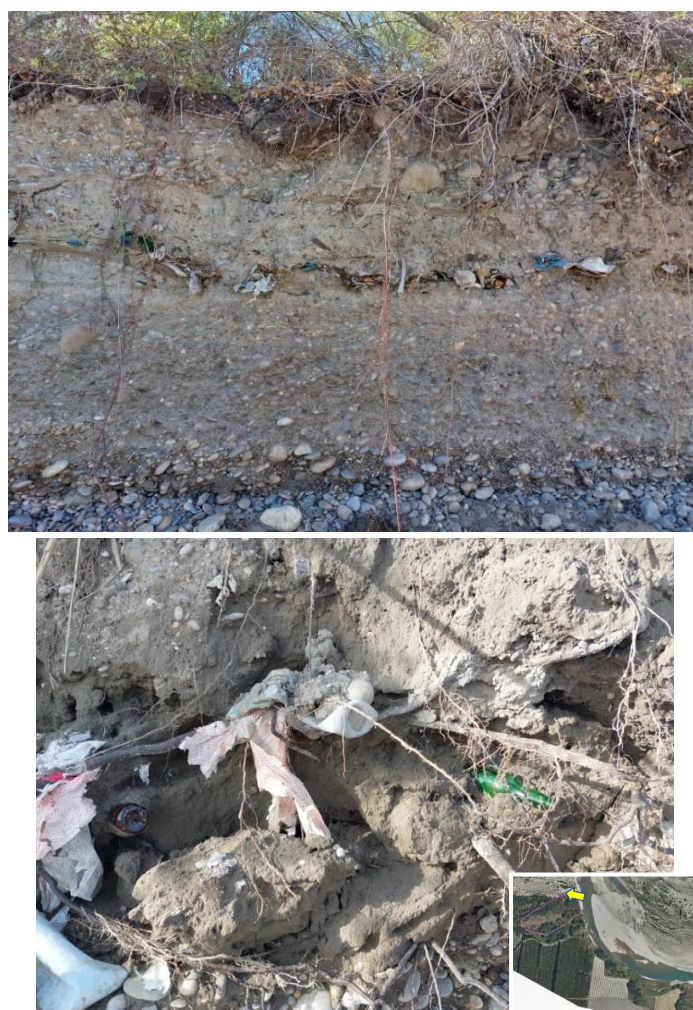
Figure 7 : Déchets visibles dans la berge érodée
