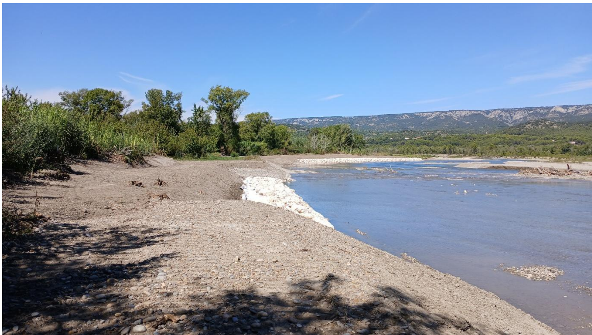
Figure 12 : Photographie après travaux du lot 1 du chantier, prise au niveau du 1 er épis déflecteur
