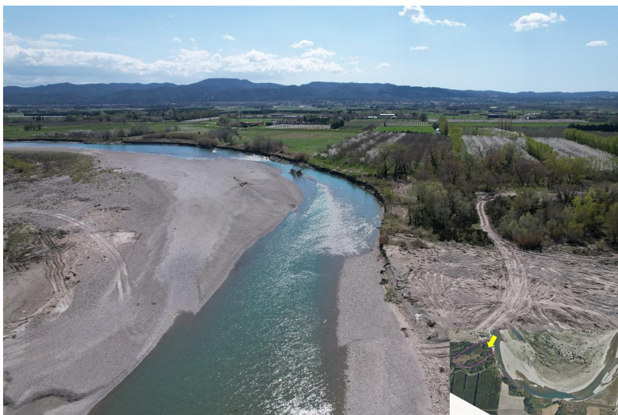
Figure 3 : Vue drone n°2 du site projet de la décharge de Charleval avant travaux
