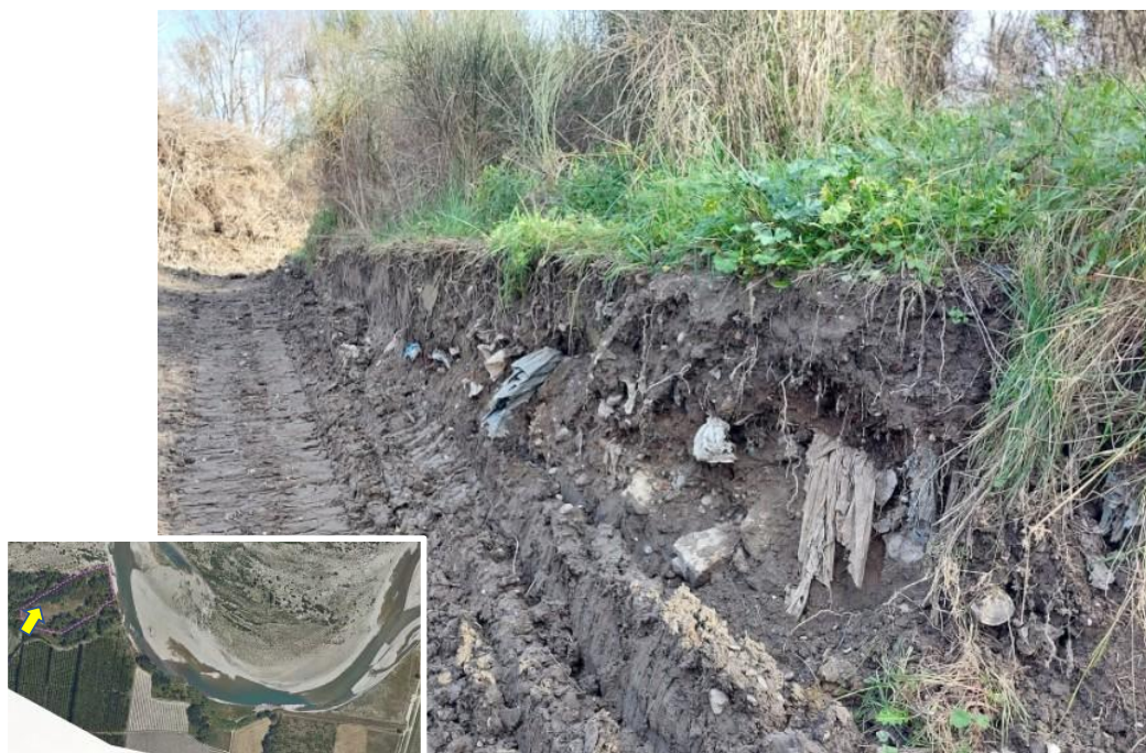
Figure 8 : Limite ouest de la décharge, déchets visibles dans les terrains au niveau d'une piste utilisée par EDF pour faire l'essartement des berges de la Durance
