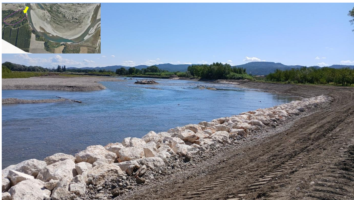
Figure 10 : Photographie après travaux du lot 1 du chantier, prise au niveau du parement de protection de la décharge
