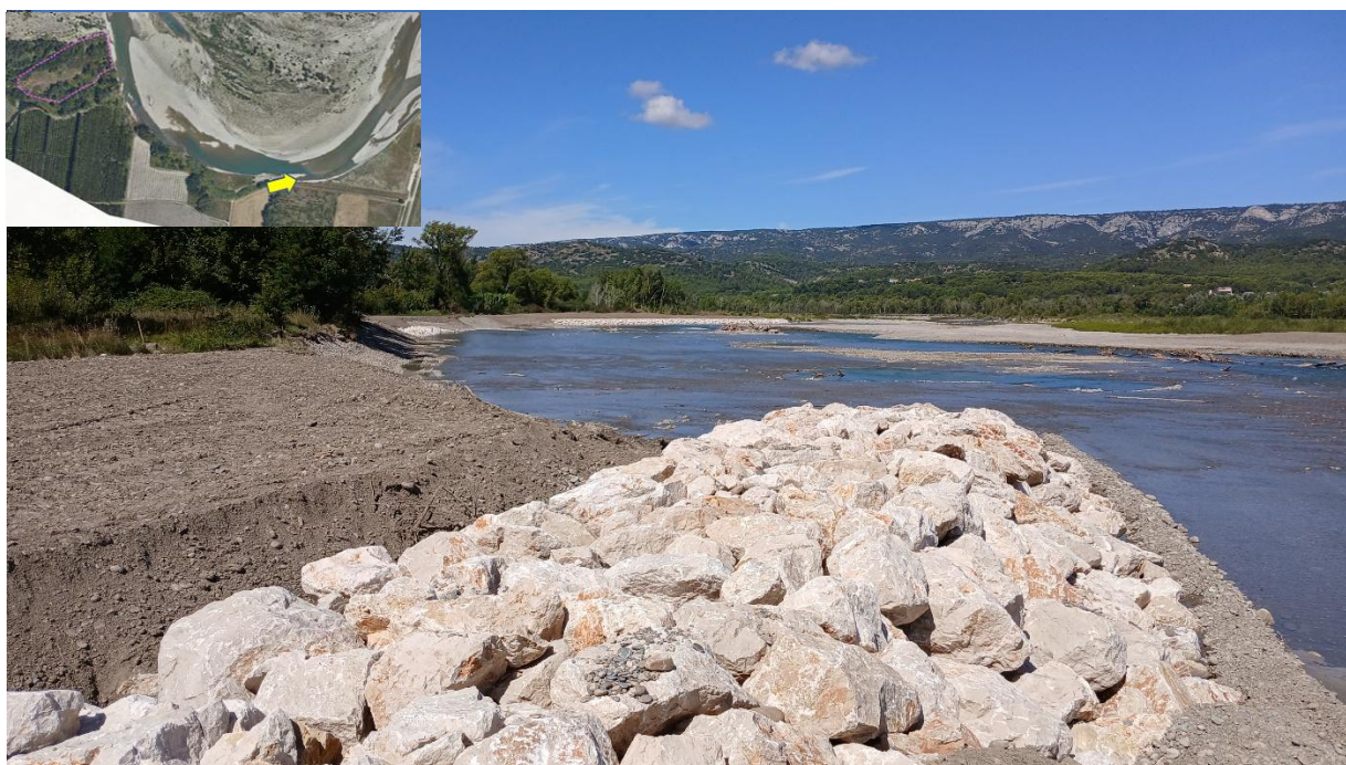
Figure 11 : Photographie après travaux du lot 1 du chantier, prise au niveau du 2 ème épis déflecteur
