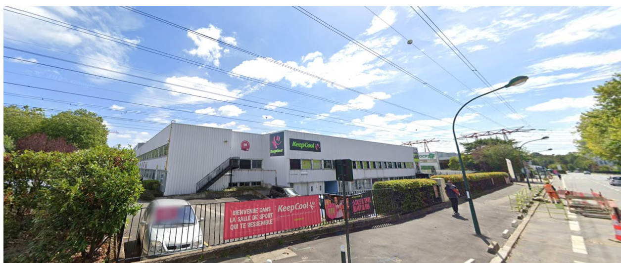
Site de projet avant enfouissement des lignes (source : google street view août 2020)
