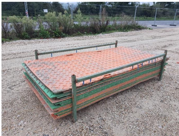
Exemple de plaques permettant la portance des engins sur sol meuble/humide (© THEMA Environnement)
