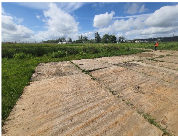
Exemple de plaques mises en place sur sol meuble/humide dans le cadre d'un chantier (© THEMA Environnement)
