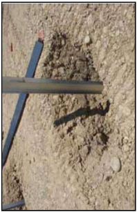
Ancrage par pieux battus (source: ZE Energy)
