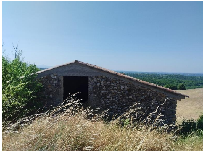
Bâtiment abandonné dans l'aire d'étude immédiate, où a été observé le Petit rhinolophe
