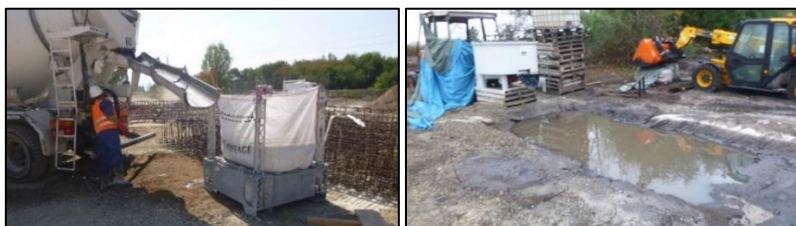
Dispositifs de récupération des eaux de nettoyage © ETEN Environnement
