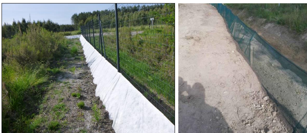
Implantation de barrières amphibiens en géotextile permettant d'éviter les déplacements des individus des fossés vers le chantier © ETEN Environnement
