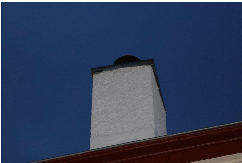
Cheminée de la gare utilisée pour le gîte de la Pipistrelle © ETEN Environnement
