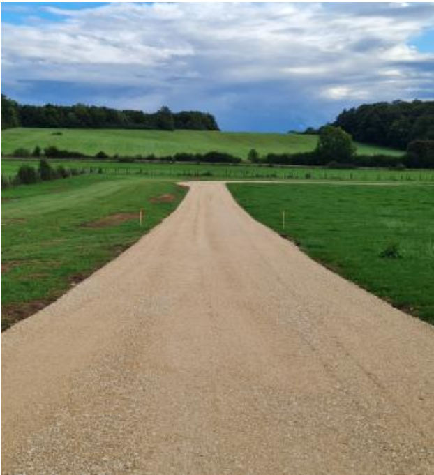
Figure 12 : Exemple de pistes d’exploitation en grave (source TSE)
