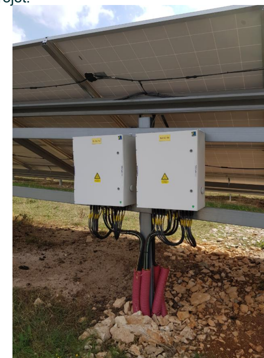
Figure 9: onduleur string (source TSE)
