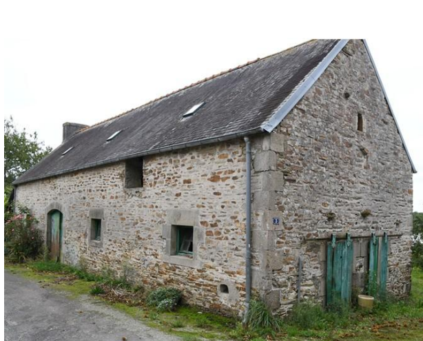
L'ancien bâtiment abritant des nids d'hirondelle
