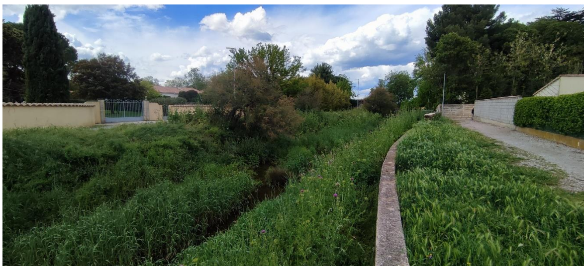
Portion centrale de transition en mauvais état de conservation avant le secteur renaturé de la Viredonne (Ruisseau de la Viredonne x Roselières et formations de bordure à grands hélrophytes autres que les roseaux, EUNIS : C2.5 x C3.2)
