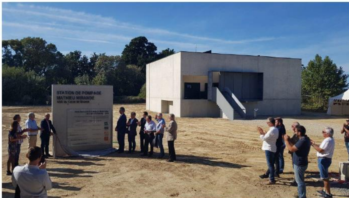
Figure 3 : Exemple de la station de pompage Mathieu MIRANDE (ASA du Raonel)
