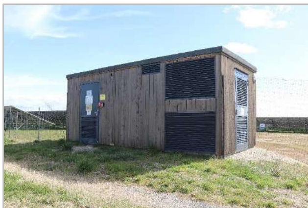
Photo 66 : Exemple de poste en bois, © TSE Energy
