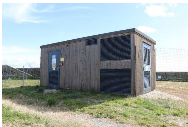
Figure 16: Poste avec bardage bois
