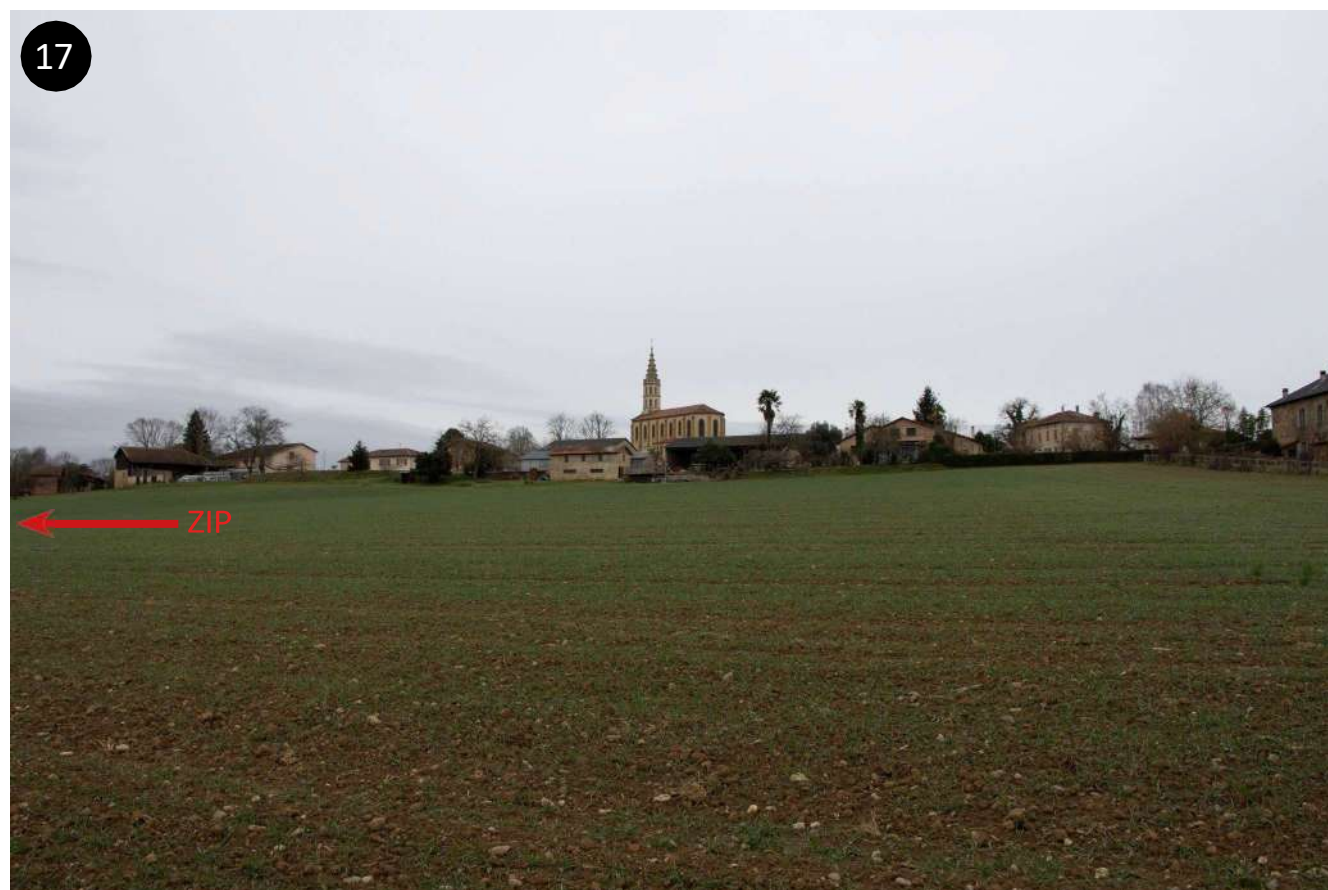
Vue de l'église de Charlas et de ses abords immédiats sur crête, le long de la RD98.
