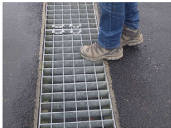
Figure 7 : Exemple de grille de type passage canadien en droit d'un chemin d'accès ((Source © A. Morand, Cerema-Est))
