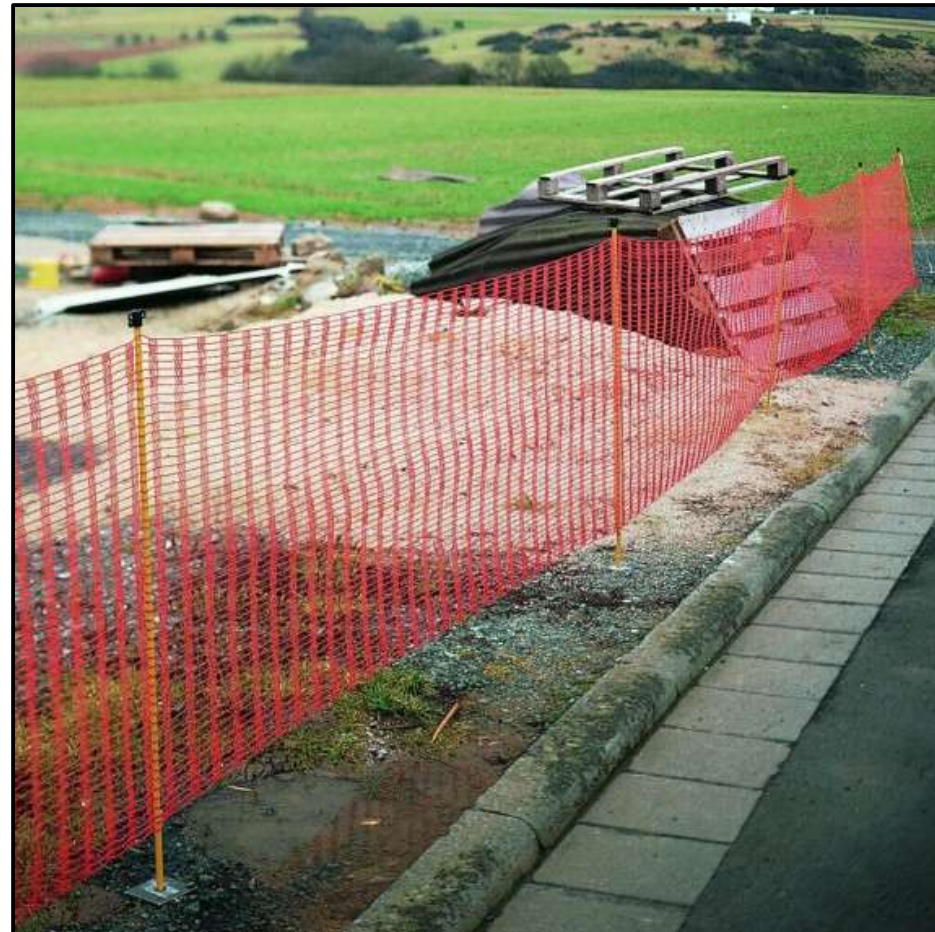
Figure 4 : Exemple de filet temporaire de chantier
