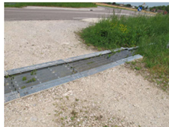
Figure 7 : Exemple de grille de type passage canadien en droit d'un chemin d'accès ((Source © A. Morand, Cerema-Est))
