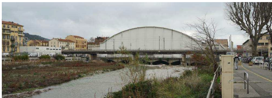
Figure 19 : La façade nord actuelle, un grand pignon aveugle
