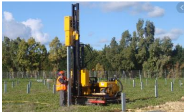
Figure 25 : Ancrage des pieux battus
