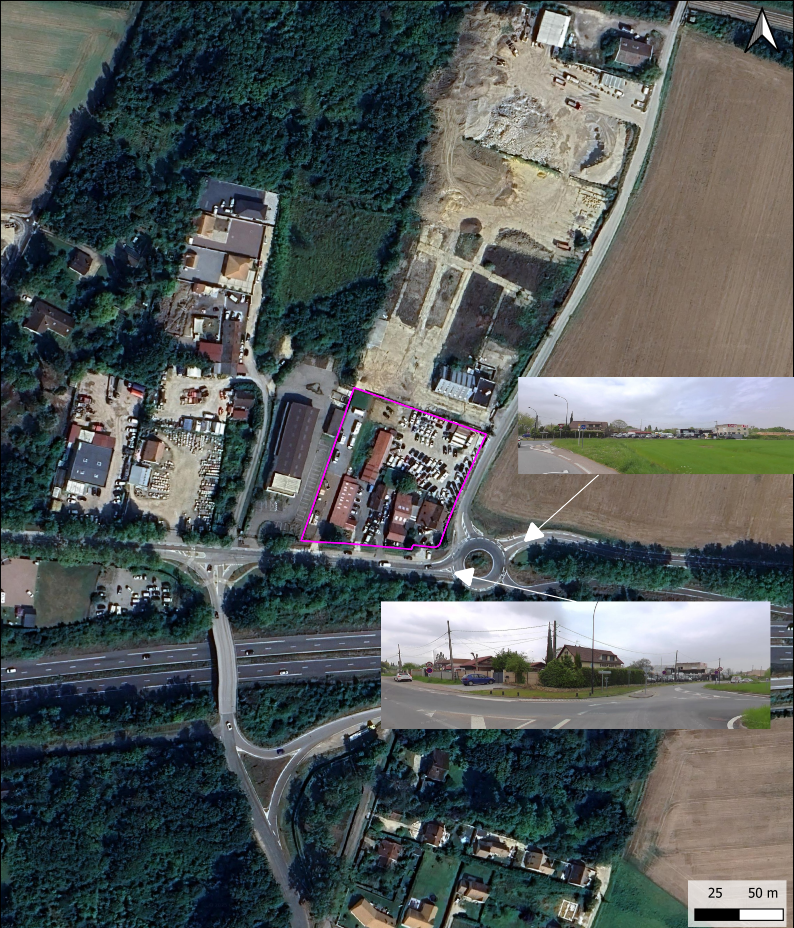
Photographie aux abords du site
