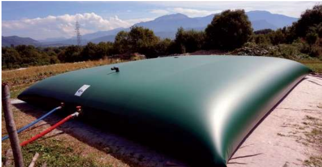
Figure 20 : Exemple de citerne incendie souple
