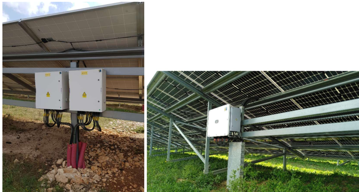
Figure 13: Exemples d'onduleurs string (source TSE)
