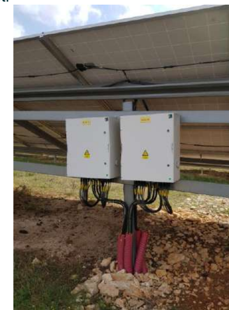
Figure 13: onduleur string (source TSE)
