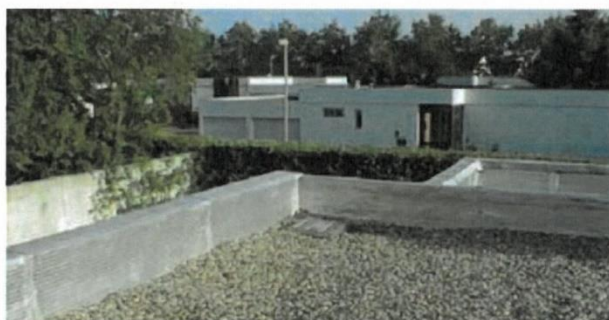
Figure 51 : Toiture-terrasse stockante (Communauté Urbaine du Grand Lyon, 2008)
