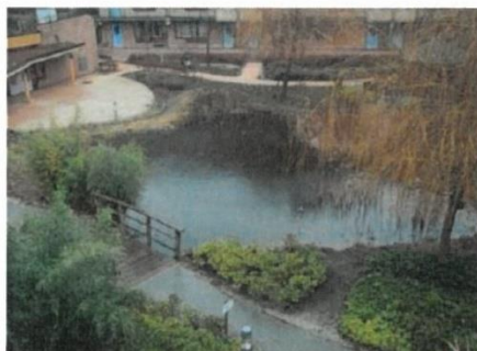
Figure 44 : Marre d'infiltration (Rombaut, 2010)
