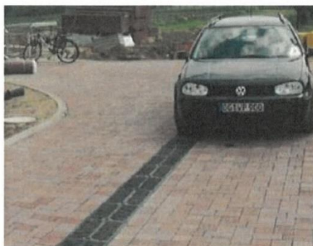
Figure 48 : Exemple de caniveau filtrant infiltrant (Funke)
