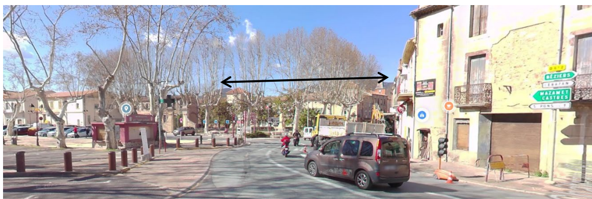
Vue sur l'Ancienne abbaye bénédictine de Saint-Chinian, insérée au sein de l'enveloppe urbaine bâtie et en arrière-plan de l'allée de platanes (Source : GoogleStreetView, Mars 2024).
