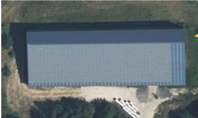
Centrale PV de Gibel
