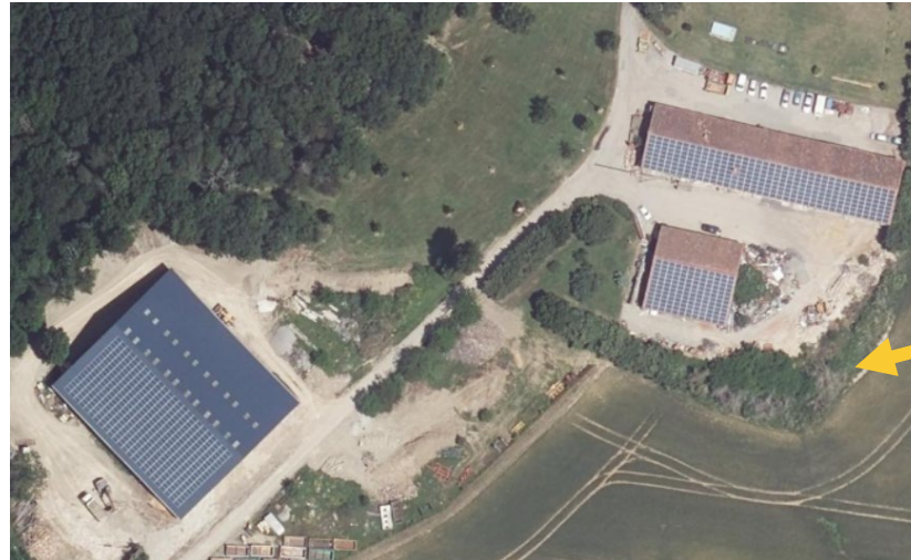
Centrale PV de Gibel
