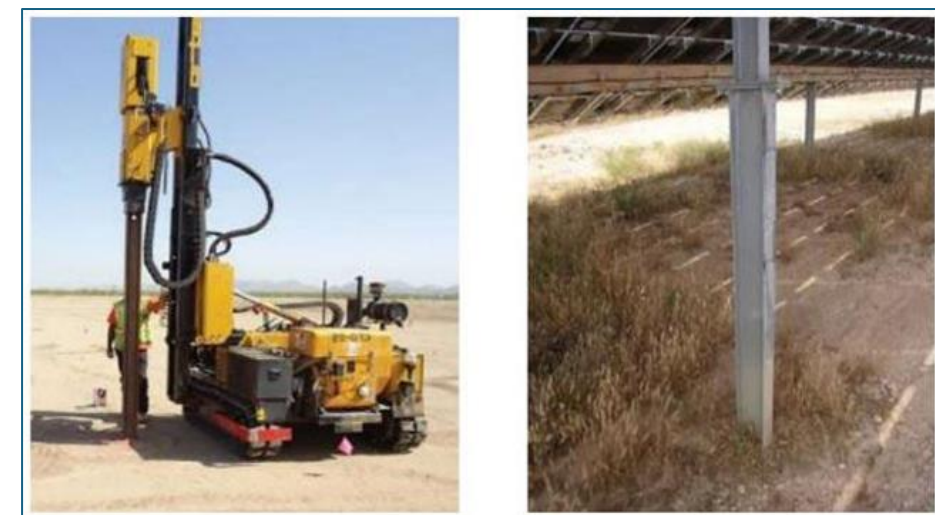
Figure 9 : Technique d'ancrage des pieux battus
