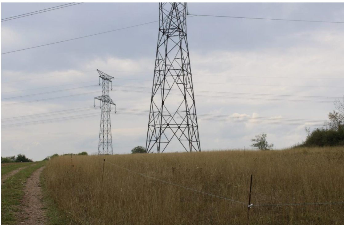
Figure 56 : point de vue partant de 1 vers la zone nord (source : BayWa r.e., 27/08/2025)
