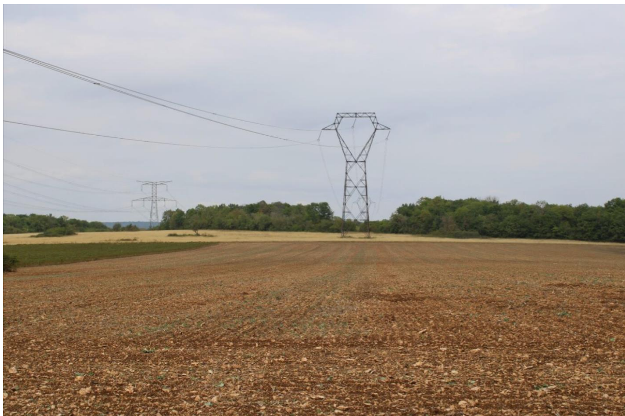
Figure 57 : point de vue partant de 2 vers la zone nord (source : BayWa r.e., 27/08/2025)
