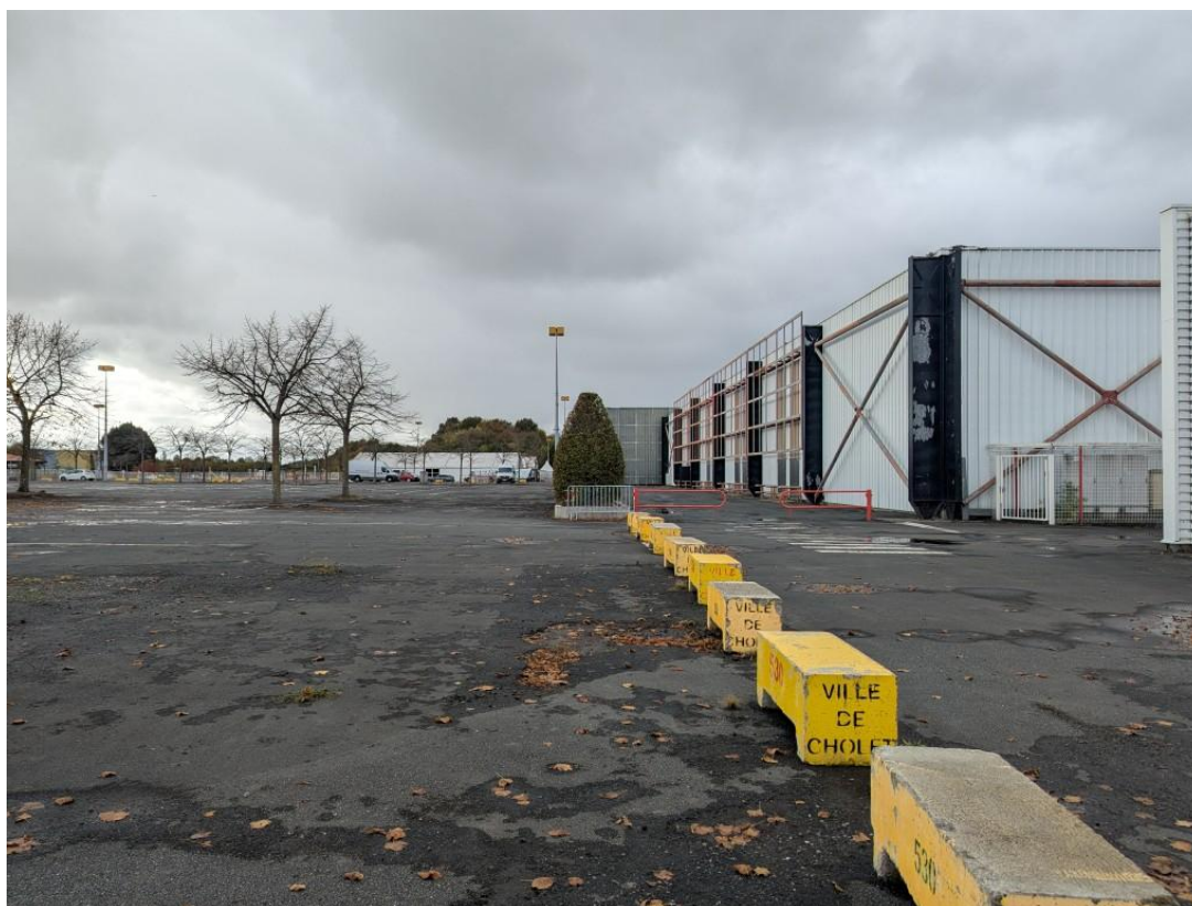
Photographie 6 : Vue sur le bâtiment « Espace vert » et le parking existant non modifié (bloc C)
