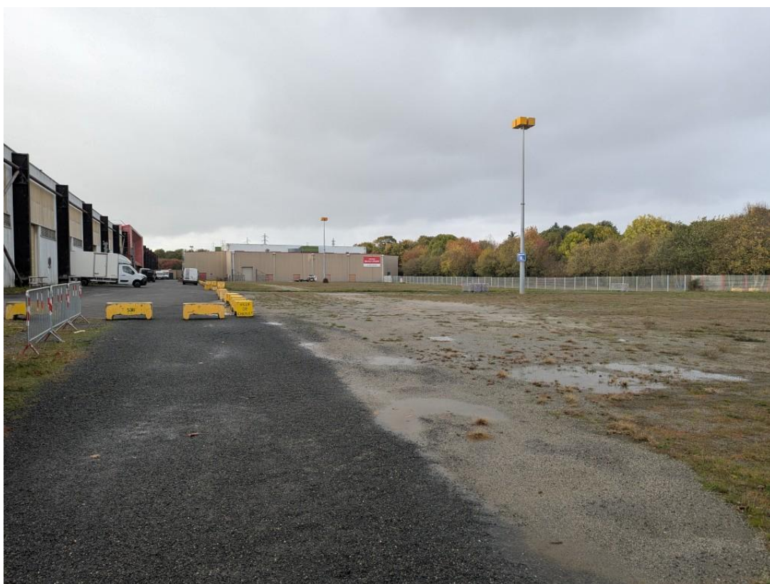
Photographie 5 : Vue sur la future aire d'exposition vers l'ouest (bloc E)
