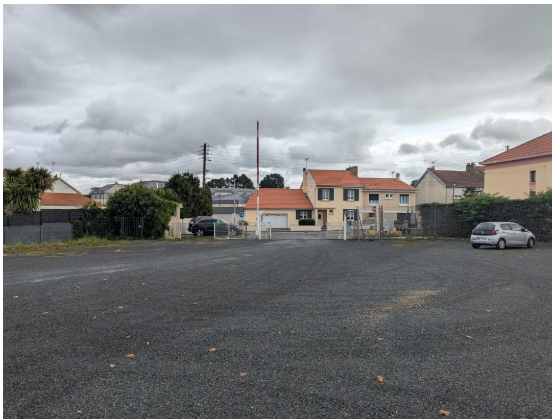
Photographie 2 : Vue sur l'entrée du futur parking paysager depuis la rue de la Mutualité (bloc D)
