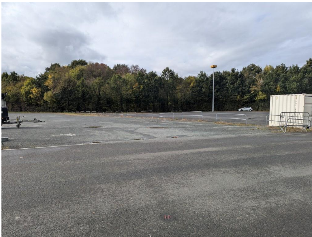
Photographie 7 : Vue depuis l'est sur le futur parking (sans ombrières) du Palais des Sports (bloc B)
