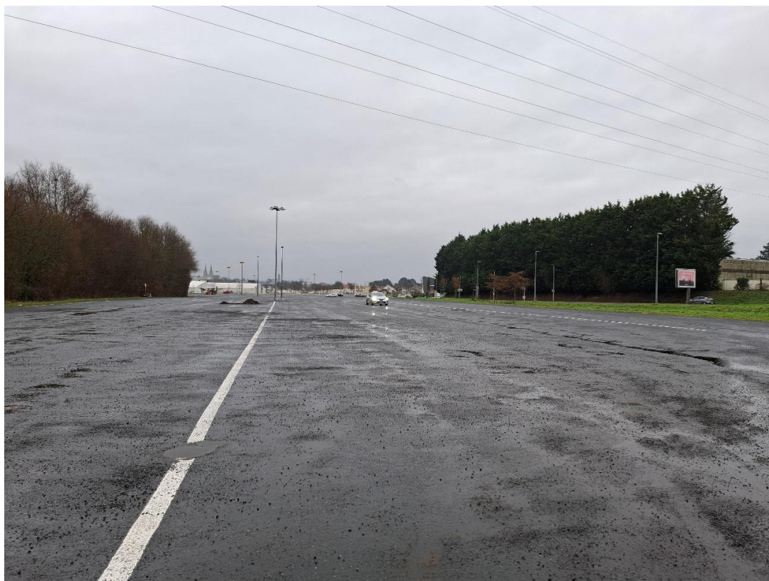
Photographie 16 : Vue depuis l'ouest sur le futur parking à ombrières (bloc A)
