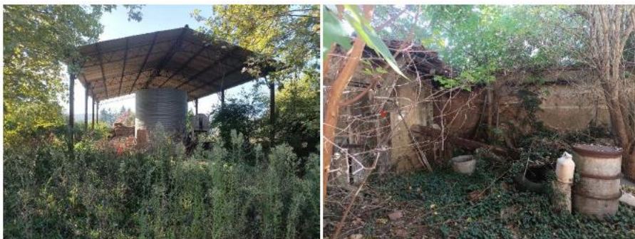
Hangar et annexe (source : Inddigo, octobre 2023)
