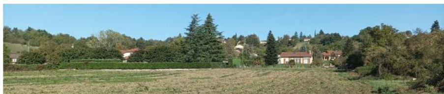
Vue vers le Nord, avec à gauche la haie de Laurier cerise + soubassement béton et à droite la partie en grillage simple (source : Inddigo, octobre 2023)
