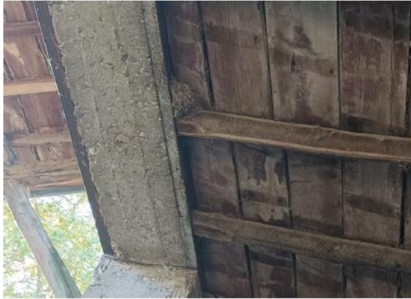
Nid d'Hirondelle rustique au-dessus de l'entrée d'une zone de stockage de matériel agricole (source : Inddigo, octobre 2023)
