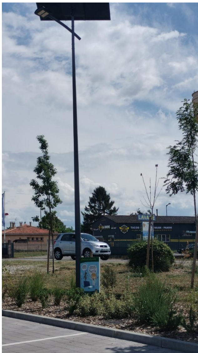
Figure 6 : Eclairage par candélabres photovoltaïques au Lidl d'Auterive 31 (Source : ADRET Nature, 2025)
