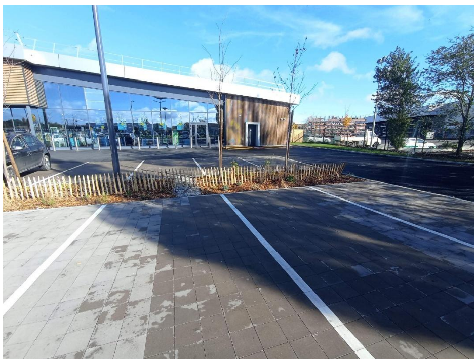
Figure 12 : Exemples de pavés drainants et noue de gestion à la source mis en place au sein de stationnements d'un Lidl existant à Auterive 31 (source : ADRET Nature, 2025)
