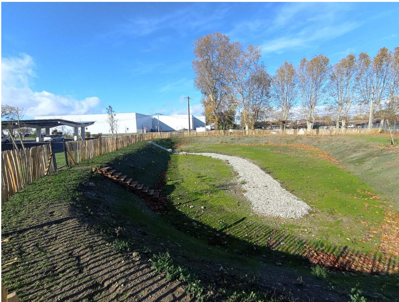
Figure 33 : Photographie d'une noue pluviale d'infiltration au sein d'un site LIDL existant (Source : VALORIS Géomètre-Expert, 2024)
