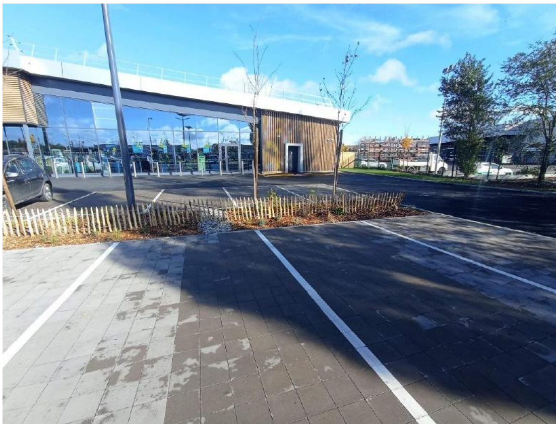
Figure 11 - Exemple de pavés drainants et noue de gestion à la source mis en place au sein de stationnements d'un Lidl existant à Auterive 31 (source : ADRET Nature, 2025)
