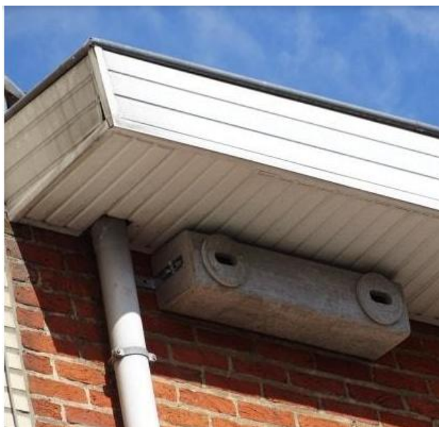
Figure 34 : Exemple de nichoirs à oiseaux intégrés aux bâtiments (source : guide bâtiments durable Brussels, s.d. ; Symbiosphère, 2022)
