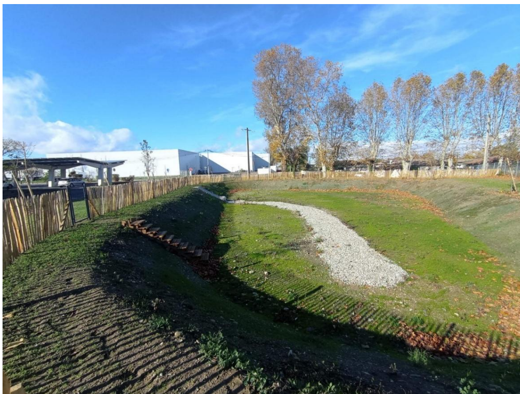
Figure 31 : Photographie d'une noue pluviale infiltrante au sein d'un site LIDL existant (Source : VALORIS Géomètre-Expert, 2024)
